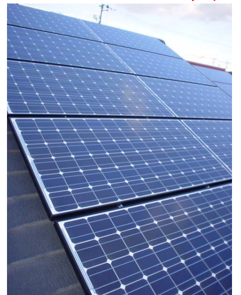
■まばゆいばかりの太陽光パネル サンヨー製単結晶モジュール
