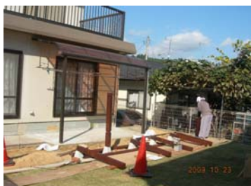
施工中/堅いウリン材に奮闘中です
