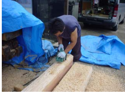
7月15日 作業場では部材の準備も本格化
