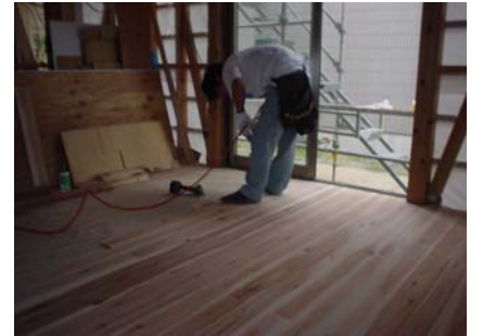
8月 床仕上げの「杉無垢材」を施工しています
